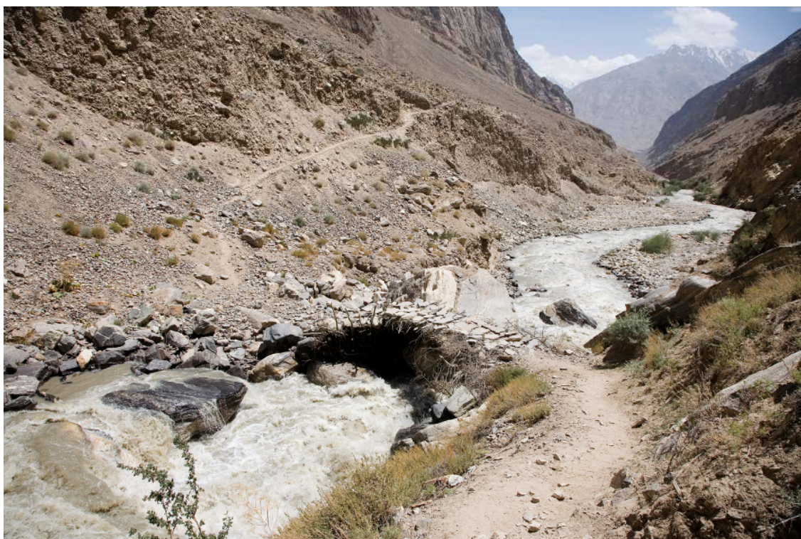
28. fotogrāfija. Tilts pār Daršai pie Pjakstonas vasaras apmetnes
